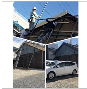
解体前の準備（ガス、電気、電話の引込配管、配線の撤去）
